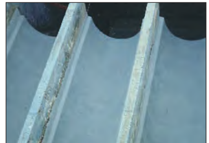
Kaikki kolme pumpun kourua on päällystetty ARC 791:llä
